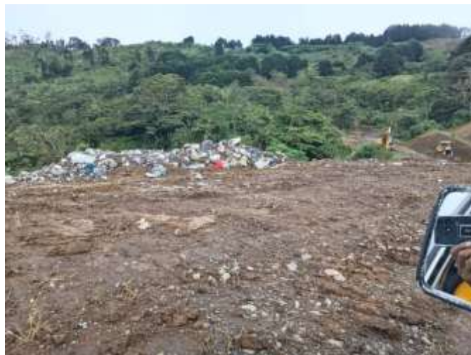
Elaboración de trabajos movimiento de tierra. Fuente: Municipalidad de Zarcero
