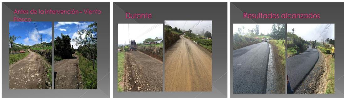
**Recarpeteo cuadrante de Zarcero**, perfilado 13.000 m<sup>2</sup> 130.000.000, colocación de carpeta asfáltica de 5 cms de espesor inversión total 130.000.000, se colocaron 1852,09 toneladas de mezcla asfáltica cuadros 45-50
