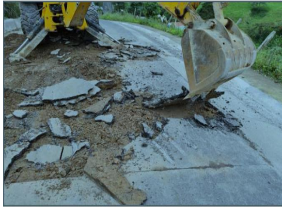
Extracción de zona afectada. Fuente propia. 2021
