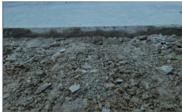
Espesor de asfalto. Fuente propia. 2021
