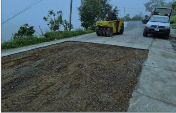
Zona afectada compactada. Fuente propia. 2021
