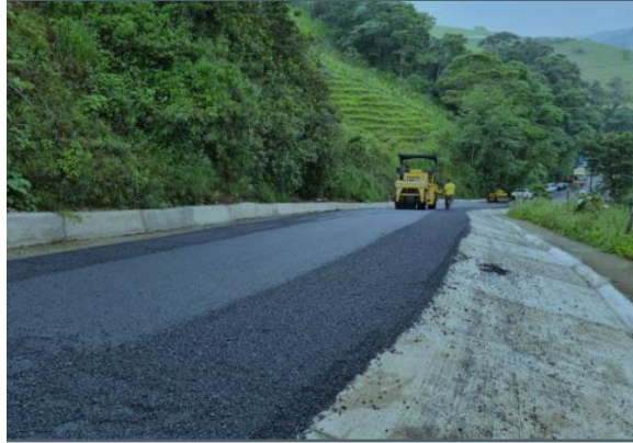
Carpeta de asfalto. Fuente propia. 2021
