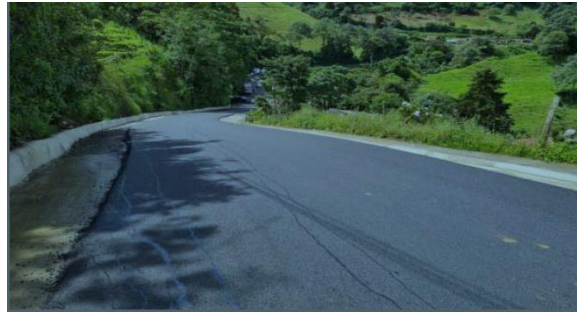
Acabado final de la carpeta. Fuente propia. 2021
